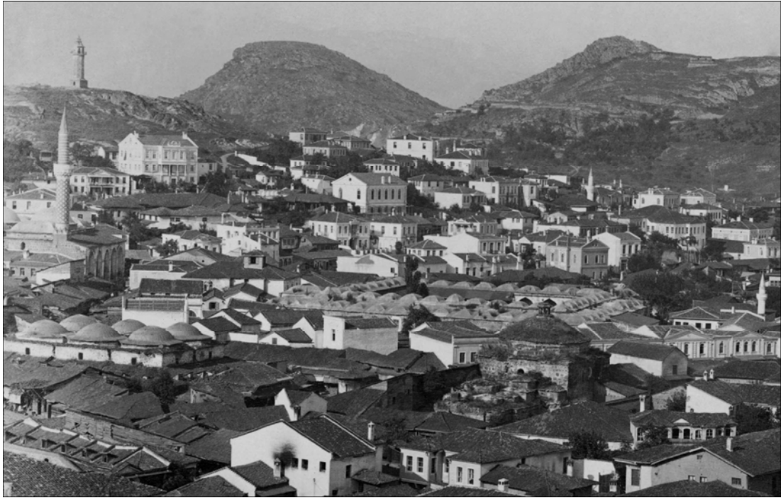
Fig. 18 Tahtakale hamamı and the kervansaray (Kurşum han) in Filibe (photo Iv. Karastoyanov, 1892)
