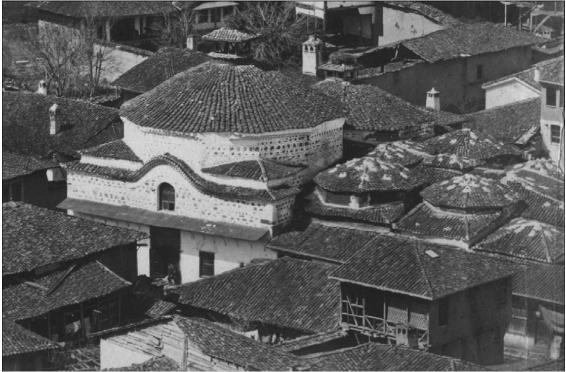
Fig. 44 Çifte hamamı in Filibe (photo D. Cavra, 1979)
